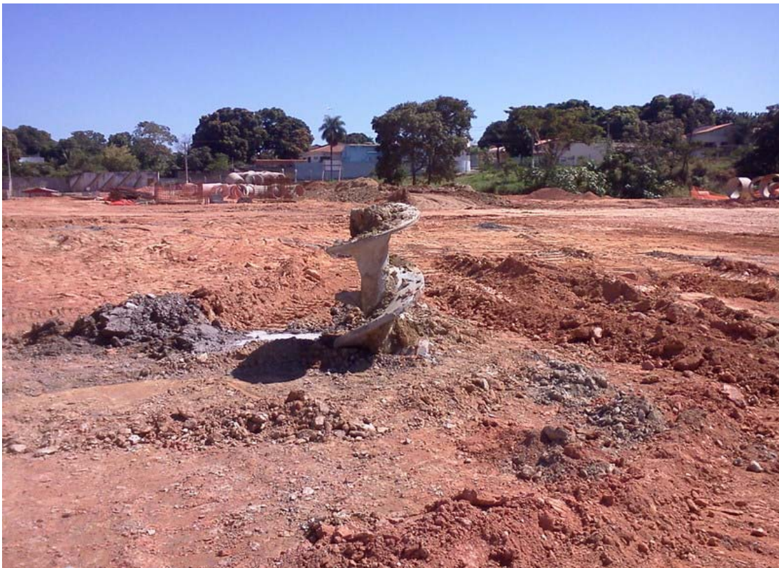
Perfuração estaca hélice
