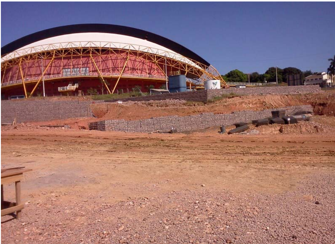
Oeste-sudoeste (muro gabião e ginásio)
